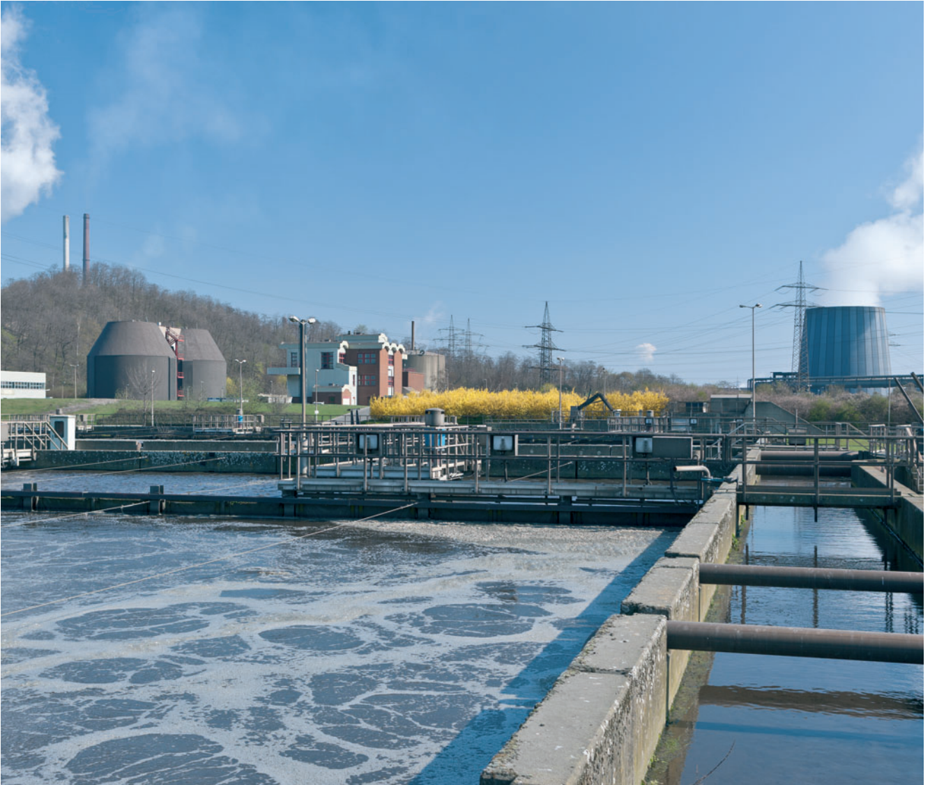
Kläranlage Duisburg, Alte Emscher
