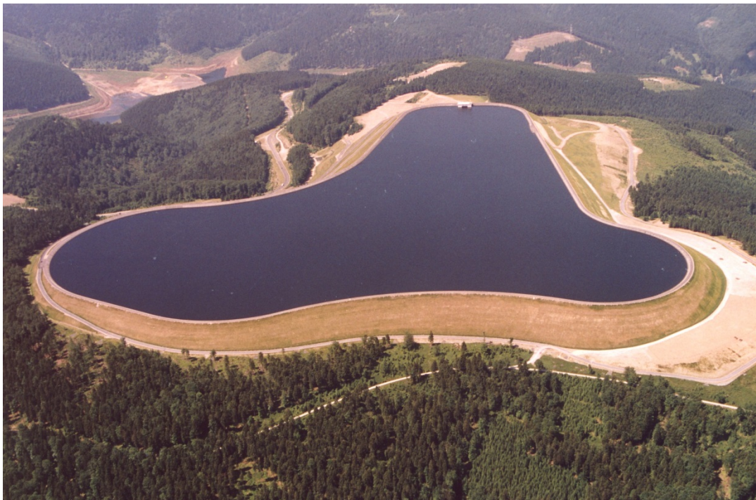
Abbildung 3: Oberbecken des Pumpspeicherkraftwerkes Goldisthal (Becken im Massenausgleich)
