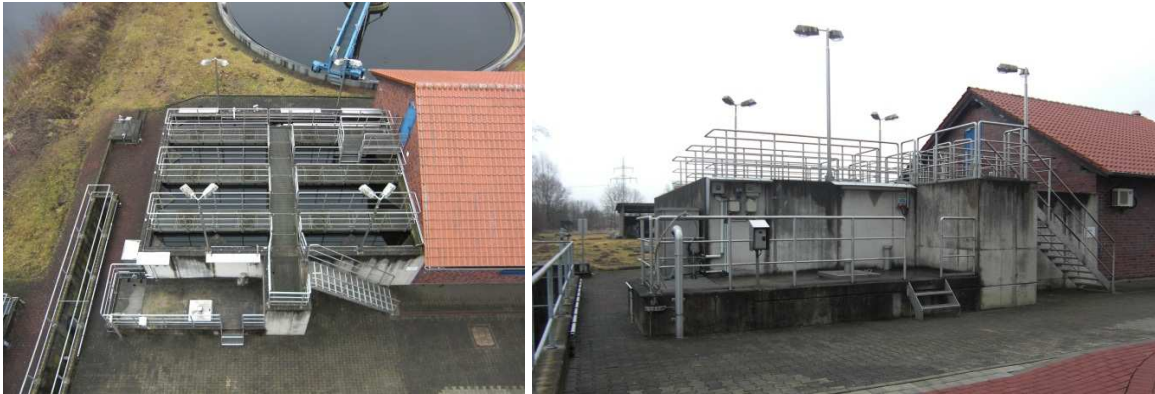
Bild 9: Dyna-Sand Filtration ZKA Rietberg
