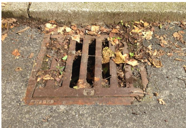
Abbildung 62: Verlegung von Straßenablauf-Aufsätzen durch Schmutz oder Laub (links) und gefüllter Schlammeimer (rechts)
