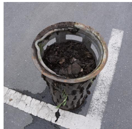
Abbildung 62: Verlegung von Straßenablauf-Aufsätzen durch Schmutz oder Laub (links) und gefüllter Schlammeimer (rechts)
