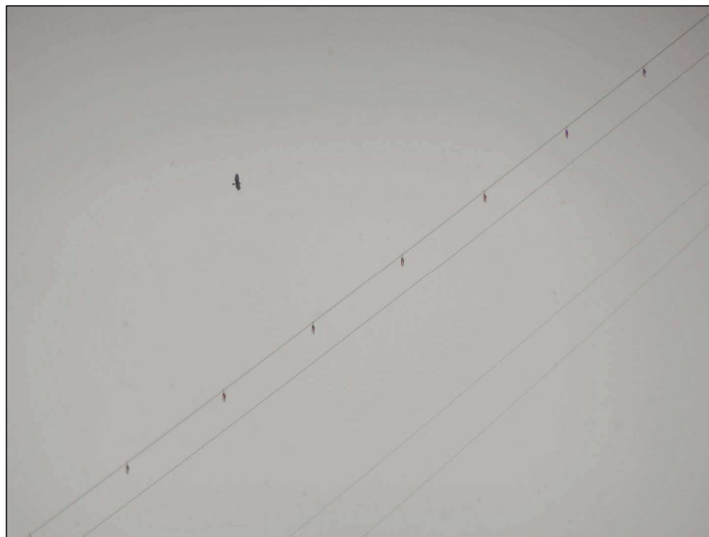
Abbildung 11: Markierungselemente an der Materialeiseilbahn Enzianhütte, Oberstdorf, mit überfliegendem Steinadler. © Henning Werth
