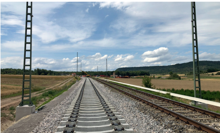
Abb. 5: Ammertalbahn, Oberleitungsmaste gestellt
