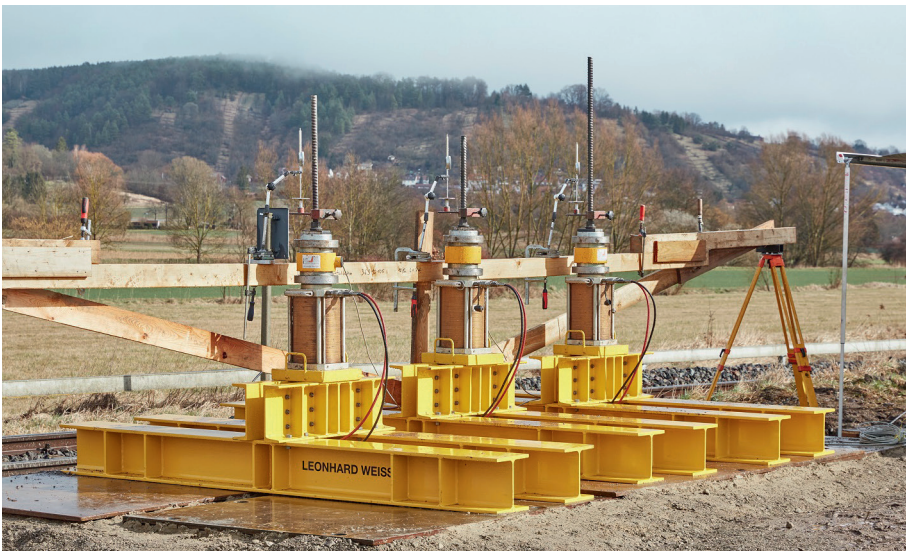
Abb. 4: Ammertalbahn, simultane Probelastung an drei Duktiramppfählen
