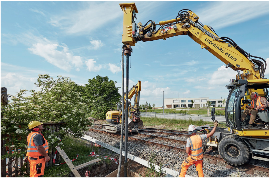
Abb. 3: Ammertalbahn, Einbau Duktiramppfahl
