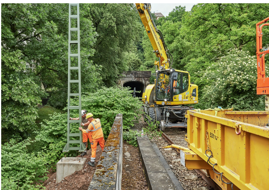
Abb. 1: Ammertalbahn, Stellen eines Flachmastes
