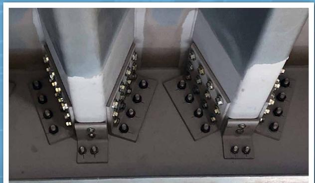
Hollo-Bolt sind eine unabhängig geprüfte Lösung für dynamisch belastete Anwendungen
