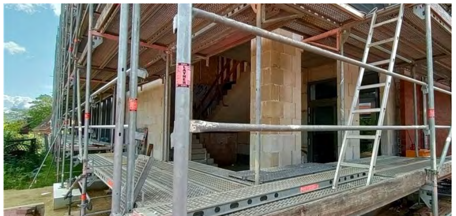
Die Baustelle heute: Das Treppenhaus am Eingang des Schulgebäudes ist jetzt regendicht. Foto: Lohmann
