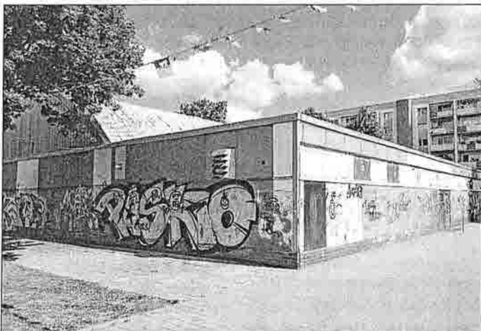
Die Sporthalle der Sekundarschule „Freiherr Spiegel“ in Halberstadt wird bald saniert. Foto: Jörg Endries
