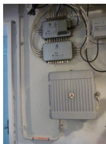
BEP unter der CATV-Verteilung
