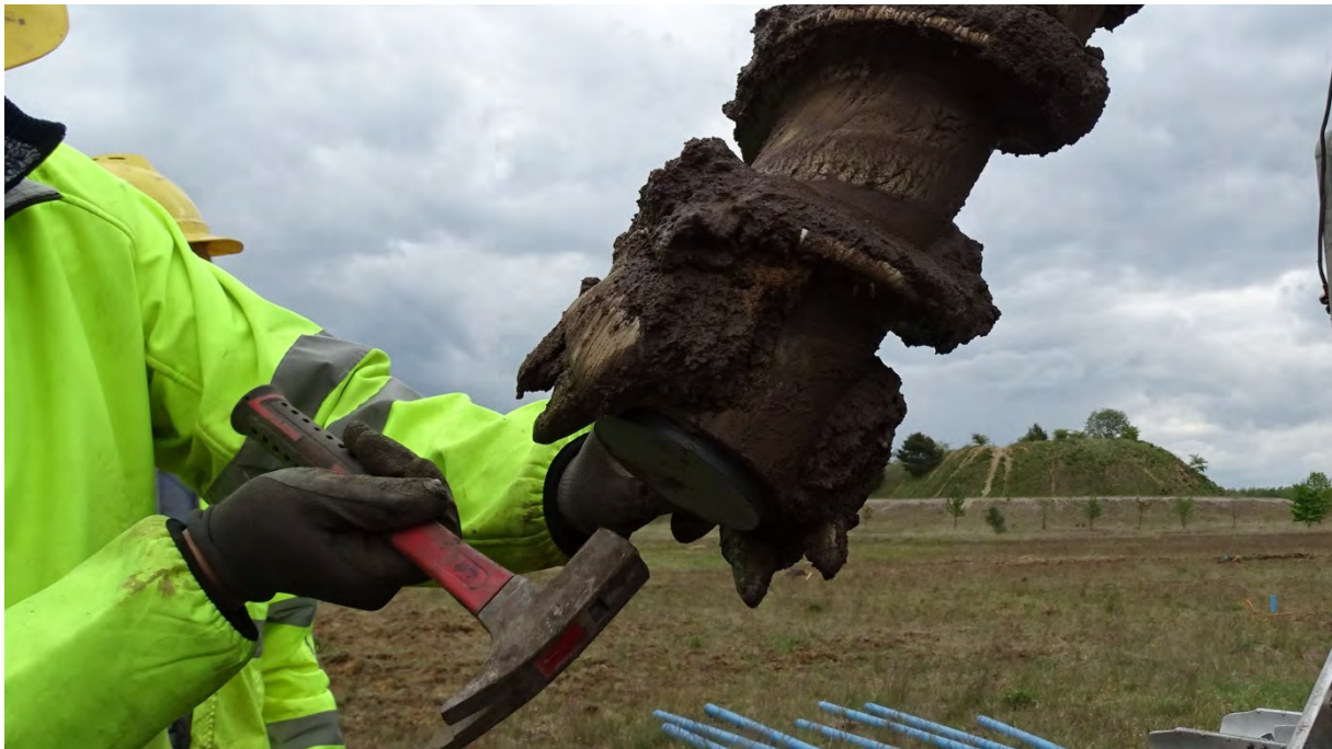
Abbildung 8: Einbau der verlorenen Krone
