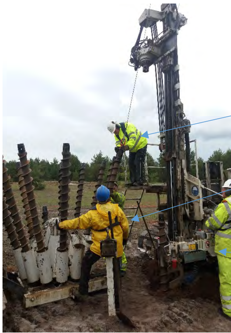
Abbildung 6: Einbau des Gestänges – ringförmiges Magazin
