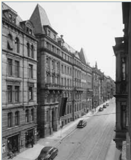
In der Stuttgarter Heusteigstraße 45 tagten von 1947 bis 1961 die Landtage von Württemberg-Baden und von Baden-Württemberg. Hier wurde am 25. April 1952 das Land Baden-Württemberg gegründet und am 11. November 1953 die Verfassung des Landes verabschiedet.
