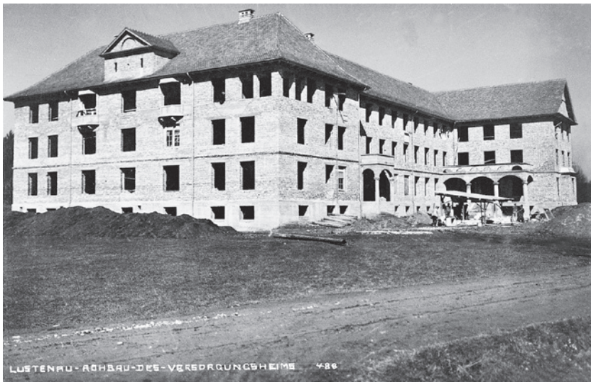
Rohbau des Versorgungs- und Entbindungsheims – nach Plänen von Willibald Braun, im sogenannten Heimatstil. Foto: unbekannt
