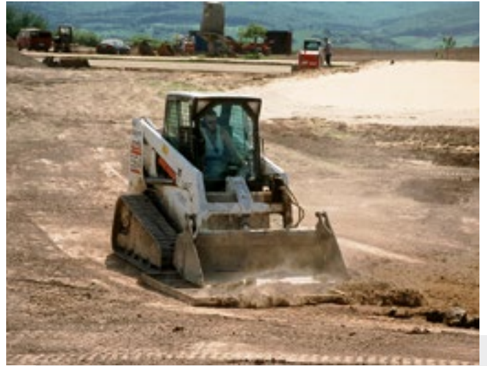
Bild 15: Gerade auf Golfplätzen muss das Feinplanum besonders sorgfältig erfolgen.
