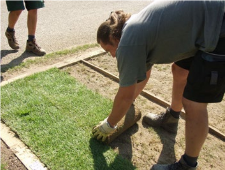
Bild 26: Der Rollrasen wird engfugig verlegt und dann angewalzt.
