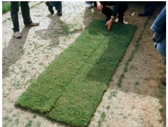
Bild 25: Bei Verzögerungen muss der Fertigrasen ausgerollt werden.
