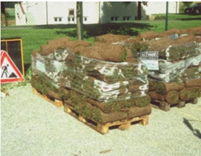
Bild 24: Die Schutzfolie ist auf der Baustelle gleich zu entfernen.
