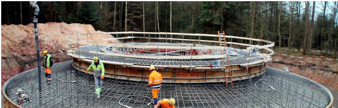
Bild 7: Fundament für eine Windkraftanlage.
