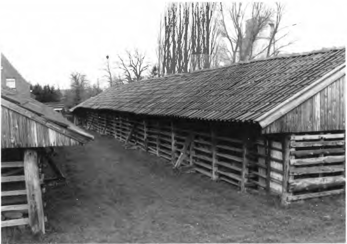
Abb.10: Trocknungslager („Trockenschuppen“) der Ziegelei Hanning bei Nordwalde (Nr. 3b).
