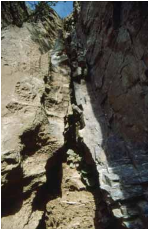
Abb. 5 Die Karstspalte verjüngt sich zum Hangenden auf wenige cm. Die Spaltenfüllung befindet sich hier bereits ca. 5m unter Massenkalkbedeckung.
