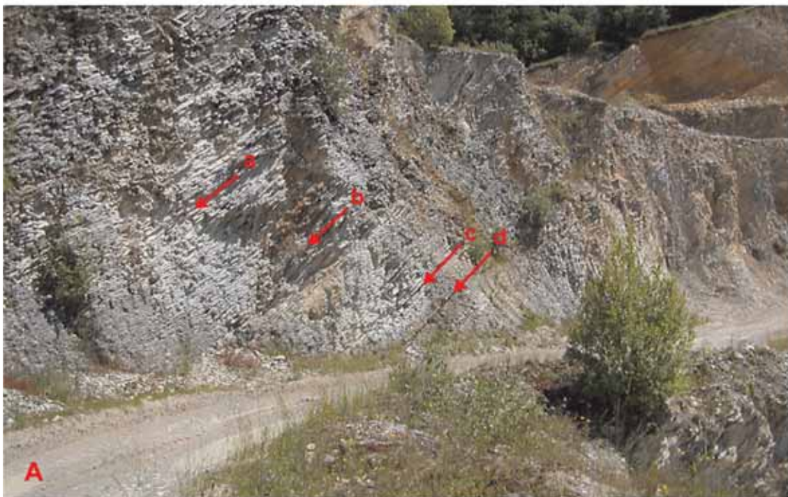
Abb. 4: Augustdorf, Schotterwerk und Bauschuttdeponie Freise & Co. GmbH, TK 25 Blatt 4018 Lage, Rechts 3484230, Hoch 5754671, 232 m, NN + 230 m. A Nordseite, Salder-Formation, basales Oberturonium, basale Subprionocyclus neptuni -Zone, a Flintlagen, b Bereich costellatus/plana -Event, c unterliegende Mergellage von Tufflage Tc, d Tufflage Tc, B Ostseite, Salder-Formation, Subprionocyclus neptuni -Zone, e Tufflage Tf, f Mergellage Me, g Bereich Hyphantoceras -Event.
