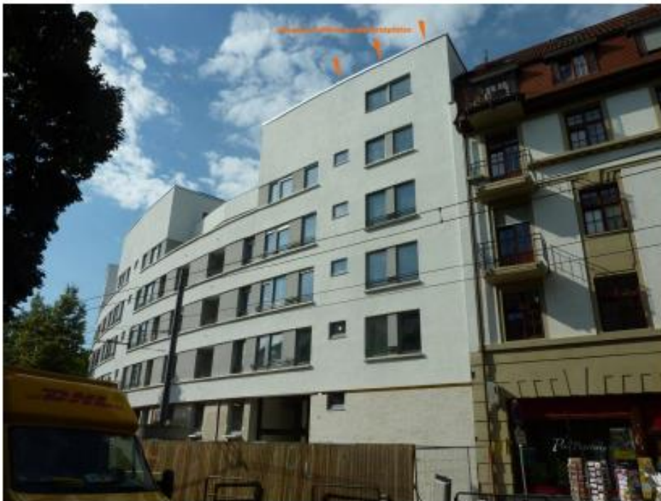
Beispiel Schwarzwaldblock, Lindenhof – integrierte Mauerseglerkästen der Firma Schwegler
