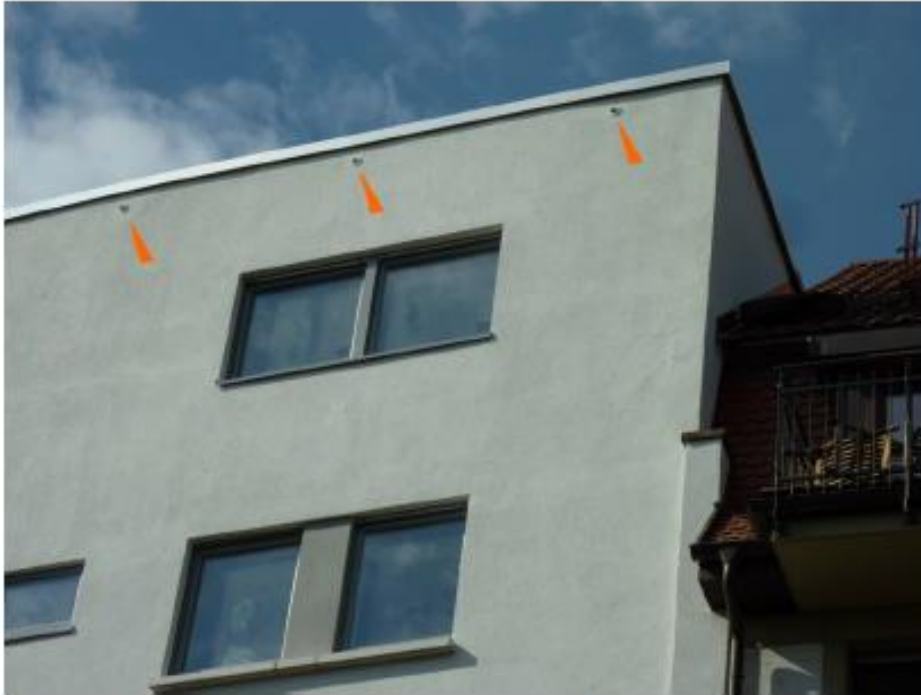
Beispiel Schwarzwaldblock, Lindenhof – integrierte Mauerseglerkästen der Firma Schwegler
