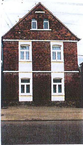
Die Außenwände sind oben mit Rückertenge auszubilden
