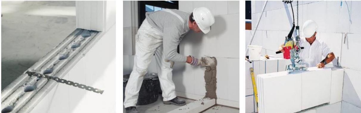
Bild 10-5: Aufmauern und anschließen einer nichttragenden Innenwand aus Kalksandstein
