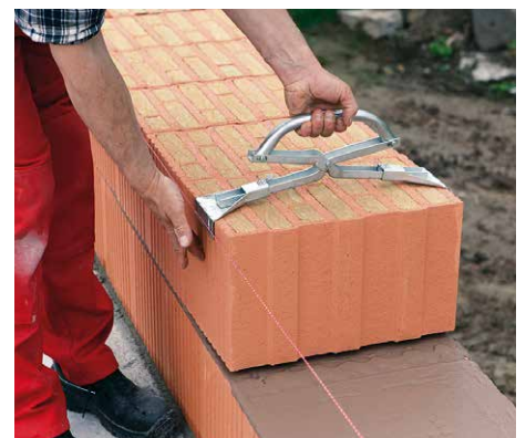
8. Wie gewohnt am Anfang und am Ende der Reihe einen Ziegel setzen und daran die Richtschnur anlegen. Dann Ziegel für Ziegel knirsch versetzen.
