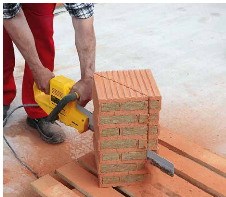
14. Schneiden mit der Handsäge
