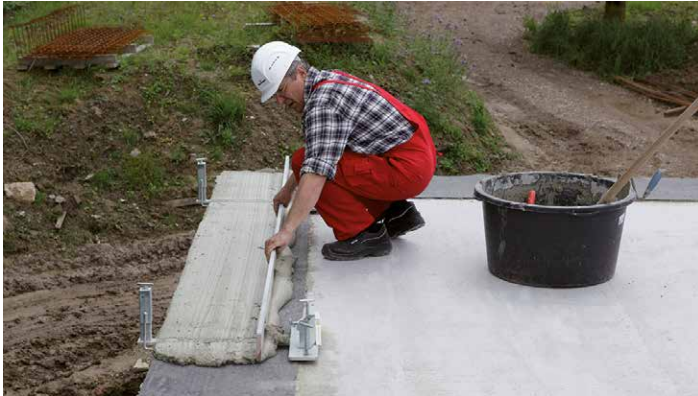
1. Anlegen des Mörtelbettes mit dem Justierboy (siehe Produktprogramm Wienerberger).
