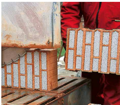
13. Schneiden vefüllter Ziegel mit der Nasssäge
