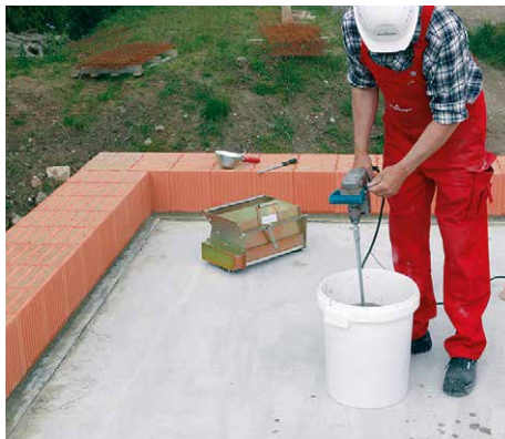
4. Dünnbettmörtel wie auf dem Mörtelsack angegeben mischen und anrühren.
