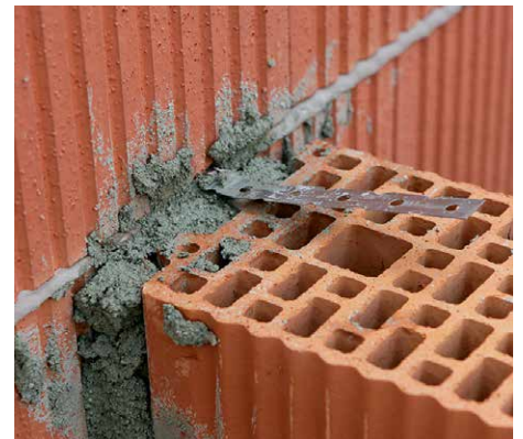
12. Innenwände werden Schicht für Schicht an die Außenwand herangemauert. Dabei müssen Sie die herausstehenden Flachanker in die Lagerfugen einbetten. Die Anschlussfuge muss satt vermörtelt werden (Mörtel bauseits, z.B. Quellmörtel).
