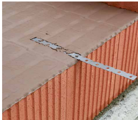
11. Vertiefen Sie zunächst die Lagerfläche der Ziegel an der entsprechenden Stelle mit einer Keramikfeile (Wienerberger Lieferangebot) um ca. 0,5 mm. Nach dem Aufrollen des Dünnbettmörtels werden die Flachanker an der vorbereiteten Stelle in das Mörtelbett eingelegt.
