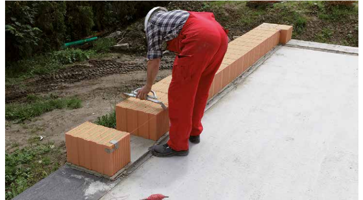
2. Ziegel für Ziegel knirsch versetzen und anschließend mit Wasserwaage und Gummihammer ausrichten.
