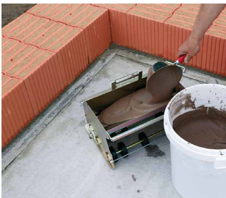
6. Jetzt wird die Mörtelrolle mit Dünnbettmörtel befüllt.
