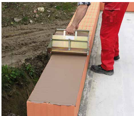
7. Schnell und einfach wird der Dünnbettmörtel auf die Ziegelschicht aufgetragen.
