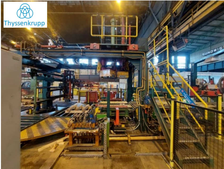
Abbildung 1: Anlage PAL1 Thyssen Krupp Steel AG Bochum
