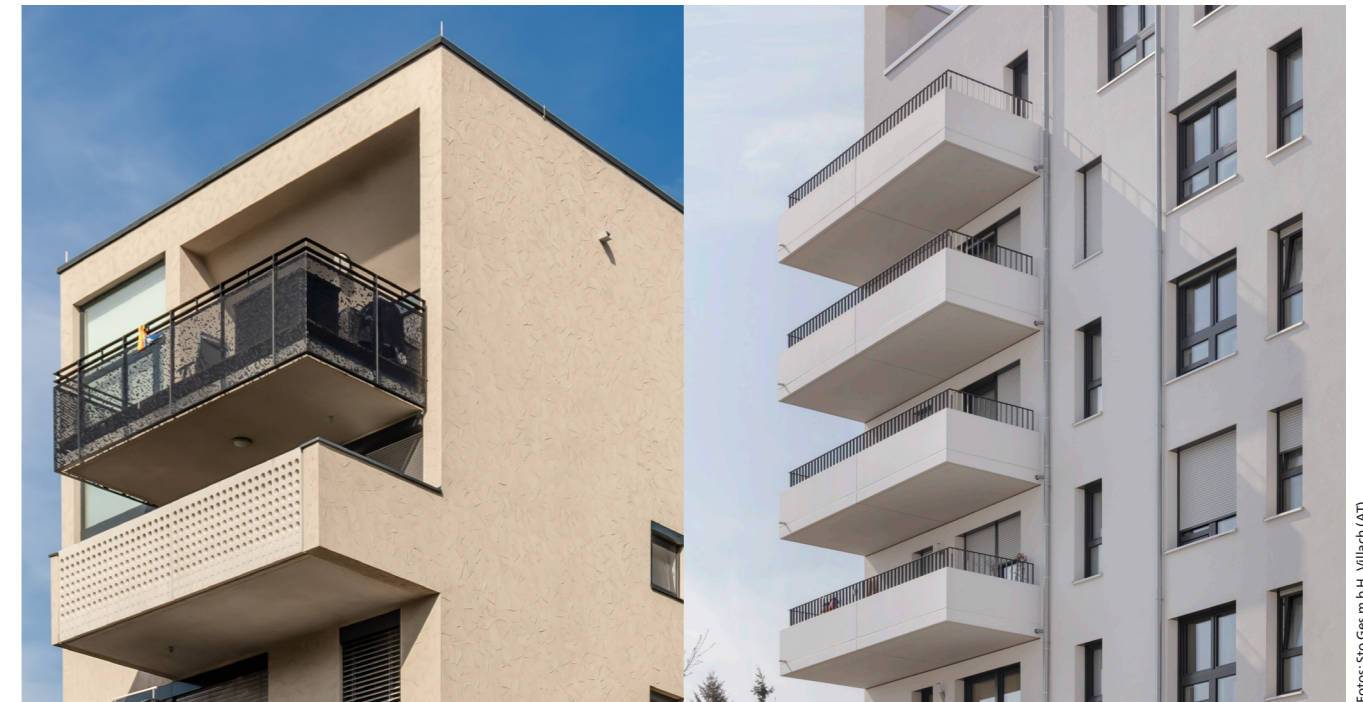
Abb. 7: Balkone an mehrgeschossigen Gebäuden
