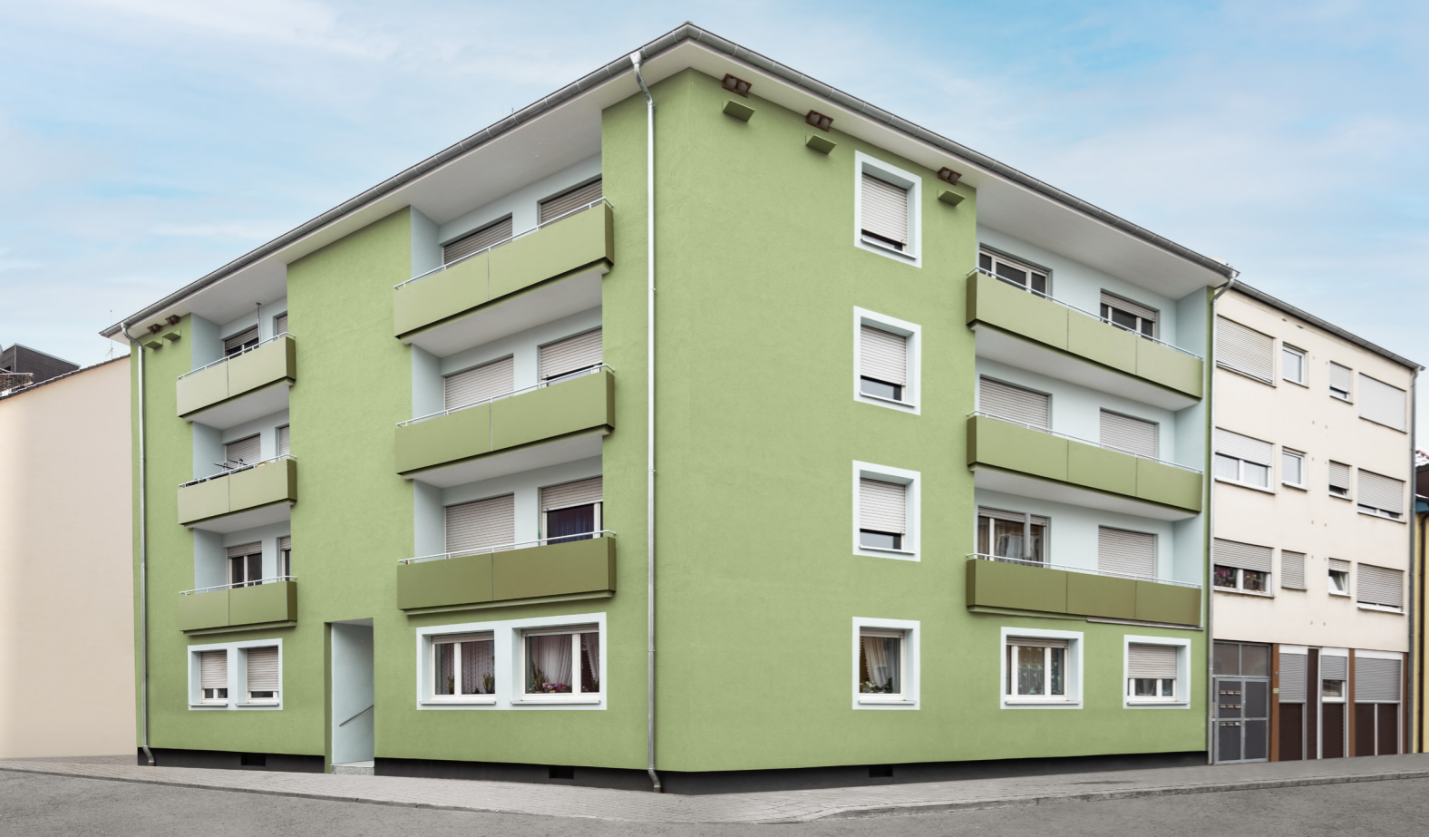
Abb. 5: Loggien in einem mehrgeschossigen Gebäude
