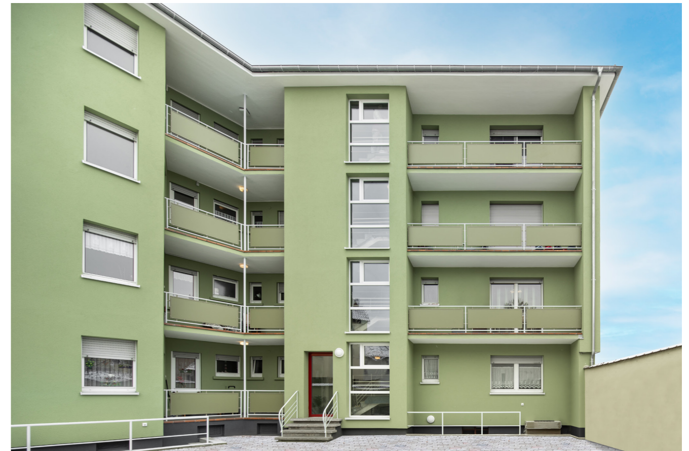
Abb. 11: Nach außen offener C-förmiger Querschnitt von Laubengängen
