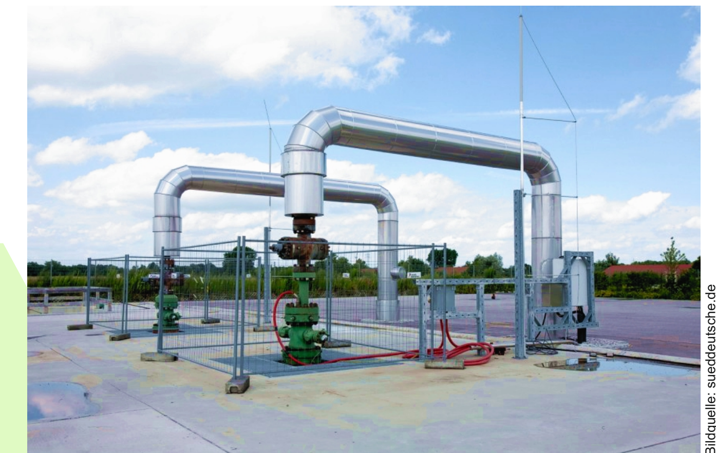
Fertiger obertägiger Ausbau mit Bohrlochkopfausbau und Leitungen
