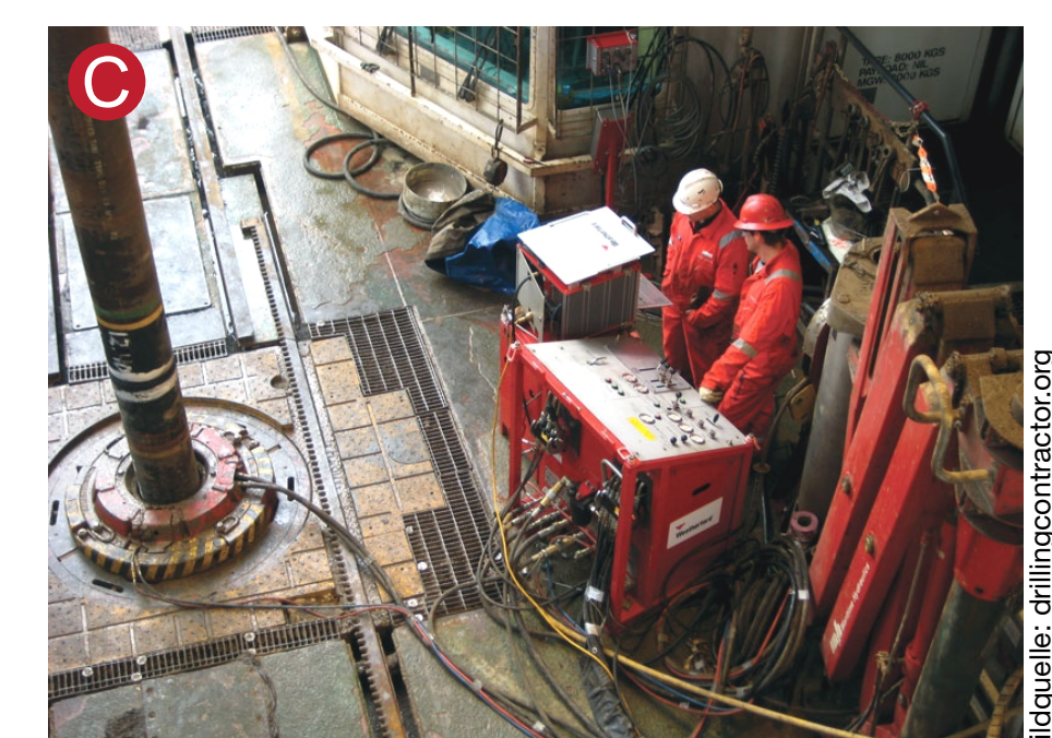
Zementationsarbeiten
