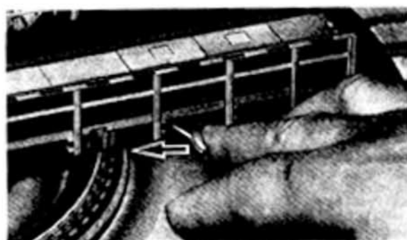
Fig. 11 Gegenüber dem Wärterhaus ist unterhalb der Drehbühne am Antrieb ein Handhebel angebracht. Durch Drücken und gleichzeitiges Halten des Hebels in Richtung Drehbühnenmitte rastet das Antriebsrad aus der Verzahnung der Grube aus und die Drehbühne kann in beliebiger Richtung verstellt werden. Nach Loslassen des Hebels greift das Zahnrad wieder ein. Darauf achten, daß die Gleisteilung der Anschlußgleise mit dem Bühnengleis übereinstimmt.
