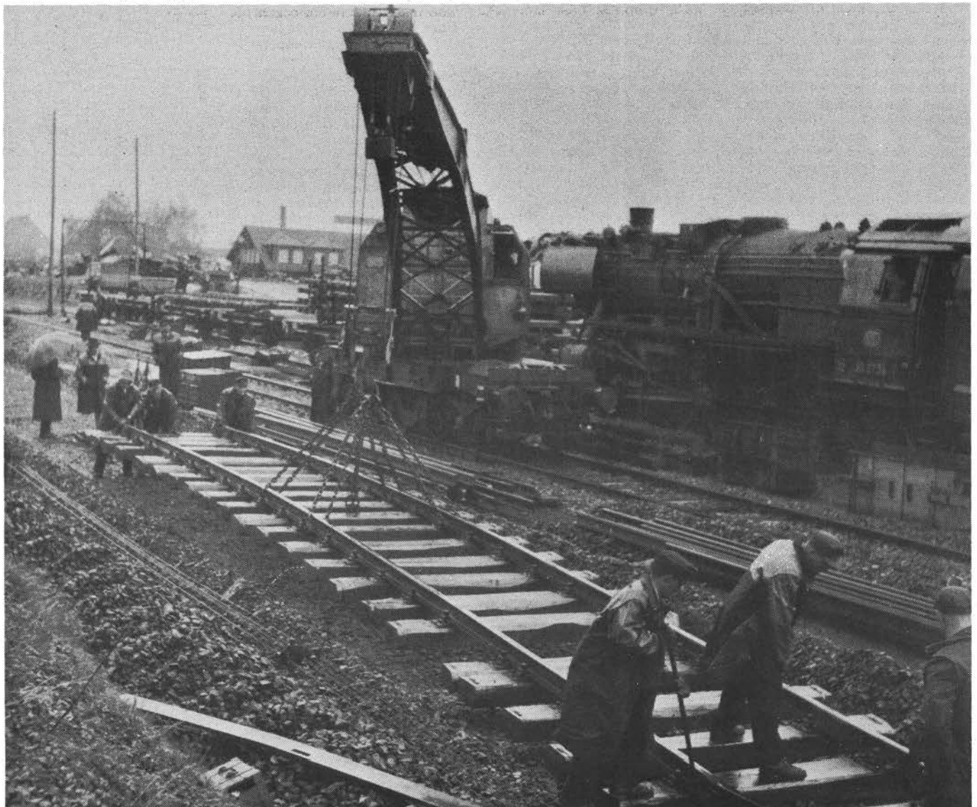
Nach wie vor Hand angelegt werden muß beim Verlegen von Eisenbahnschienen. Im Mai 1969 half im Schwenninger
