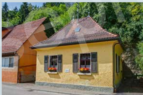
Trinkwasser-Pumpstation am HÜRBETOPF in Hüben.
