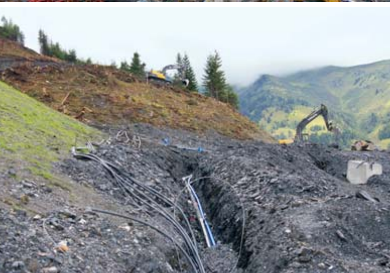
Blick auf die Rohrleitung der Schneesanlage und ein Stützenfundament im Talbereich.
