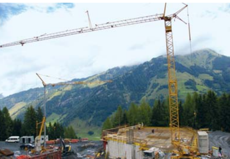
Die Talstation wird auf 1.278 m Seehöhe gebaut.
