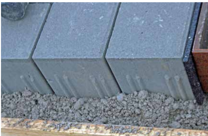
Abb. 12: Einbringung der Pflastersteine ohne Haftvermittler
