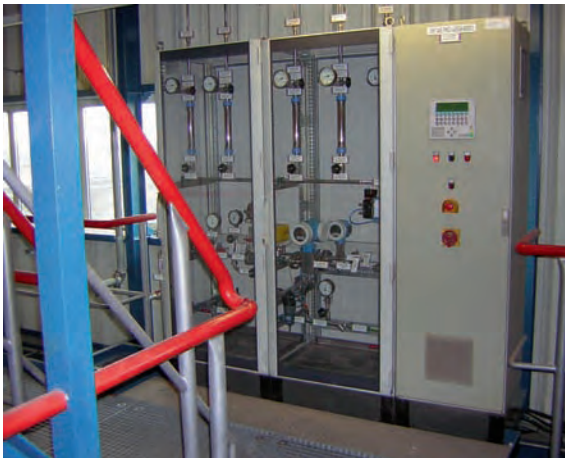
Bild 9: Misch- und Messmodul mit MSR-Schrank für Harnstofflösung
