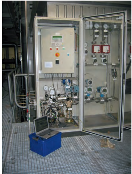
Bild 18: Serviceeinsatz am Misch- und Messmodul
