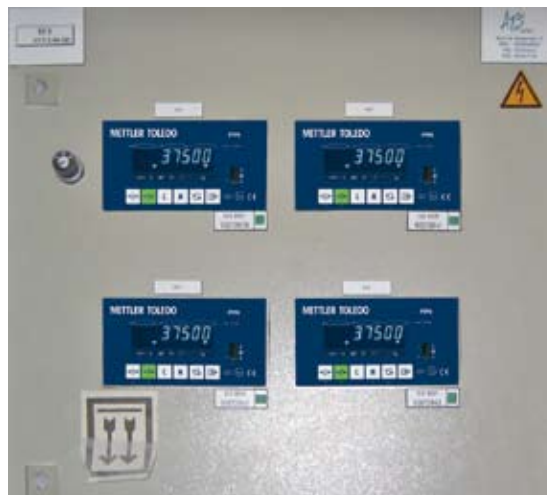
Chargieren von Rohmaterial mit PTPN-Prozessterminals
