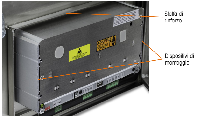
Figura 2-6: Staffa di rinforzo per pannello installata
