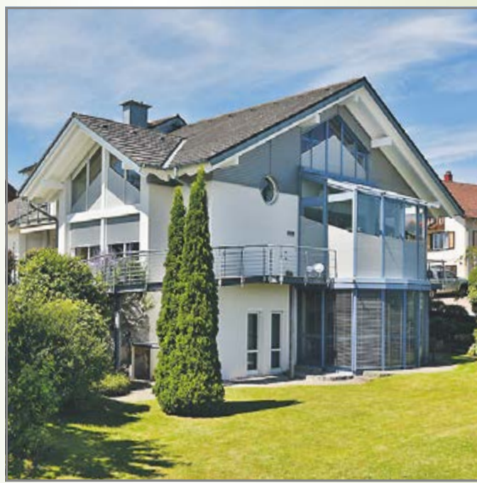
Der Austausch in die Jahre gekommener Fenster und Rollläden spart Energie, schont die Umwelt und schenkt dem Eigenheim ein völlig neues, frisches Gesicht. Foto: djd/Schanz Rollladensysteme
