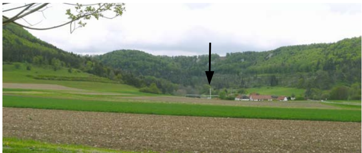
Ansicht auf die Förderanlage für Restholzentorgung vom bestehende Ortsrand von Mühlheim aus. Entfernung ca. 500 m
