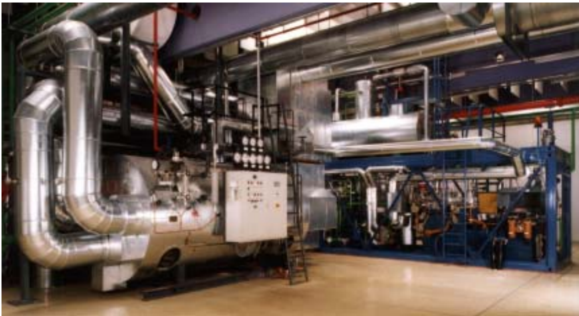
Abbildung 41: Prototypanlage für Dampfschraubenmotor an der Universität Dortmund (Quelle: UNI Dortmund)
