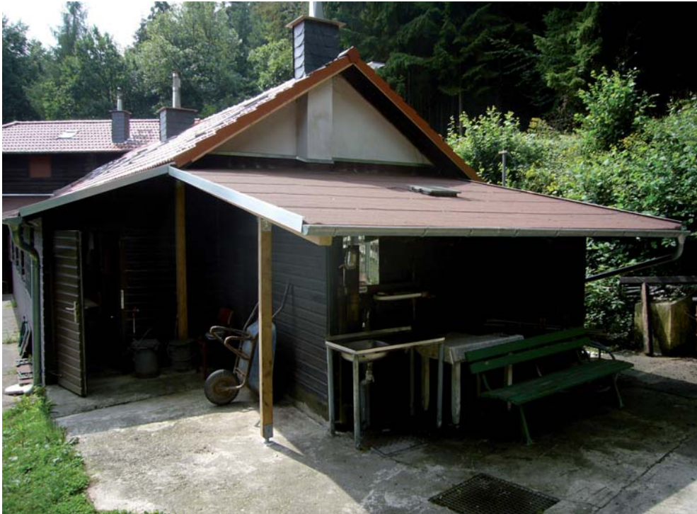
Die Hütte hat ein neues Dach
