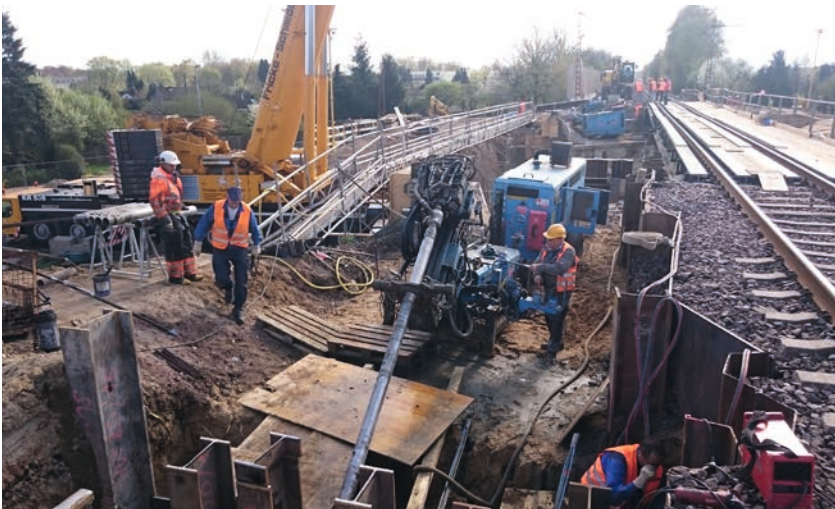
Bild 1: Beengte Verhältnisse mit zwei Kellerbohrgeräten zwischen den Gleisen
