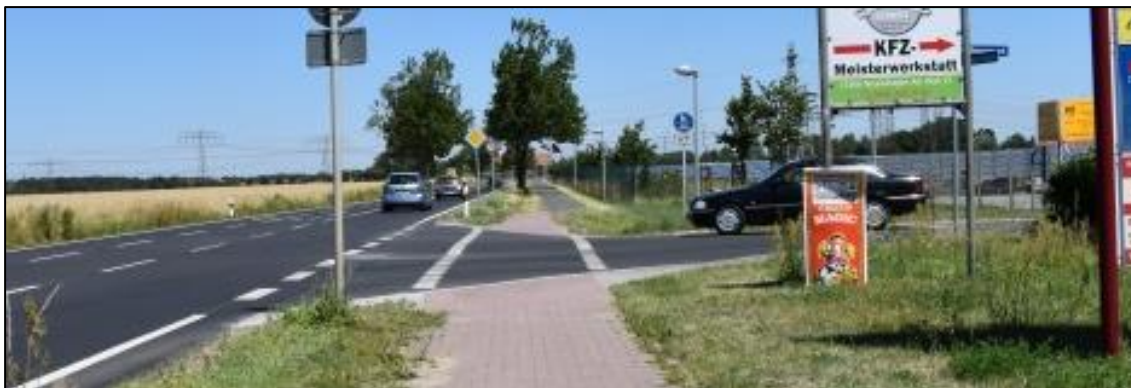
Abb. 20 Bestandssituation Knotenpunkt Altlandsberger Chaussee / Am Umspannwerk
