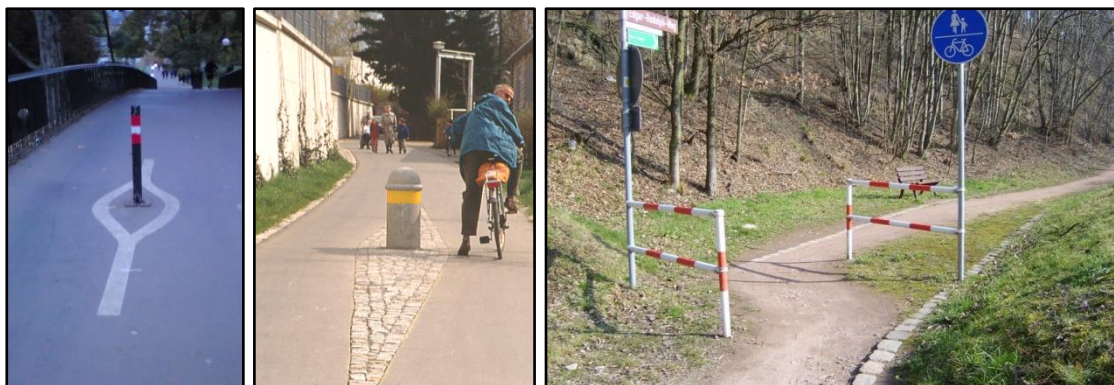
Abb. 45 Beispiele Verbesserung Verkehrssicherheit an Poller / Umlaufsperrn
