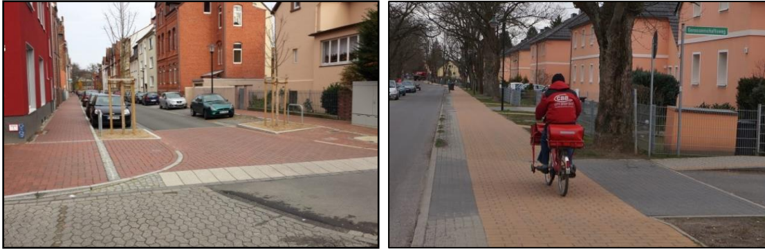
Abb. 32: Beispiel Gehwegvorstreckung / Gehwegüberfahrt
