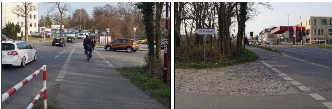
Abb. 16 Bestandssituation Knotenpunkt R.-Luxemburg-Damm / Wiesenstraße
