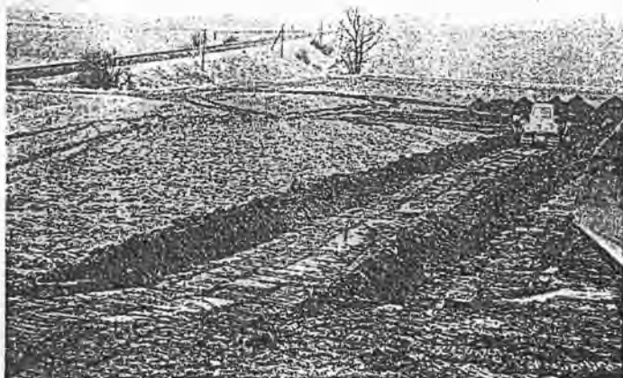
Abb. 5: Als vorbereitende Maßnahme wurde der nährstoffreiche Oberboden abgetragen. — Zu erkennen ist auf der Aufnahme vom Februar 1992 auch die leichte Südneigung der Ausgleichsfläche.
