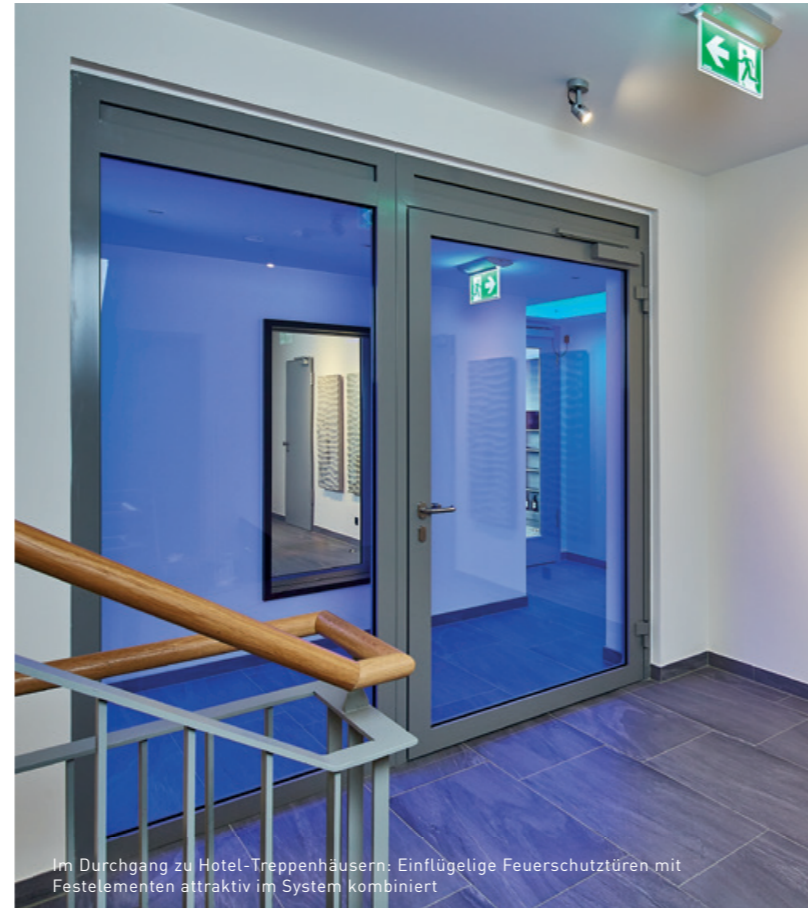
Ganzglaswände in der Ausführung T30 (EI 2 30) (auch mit integrierter Tür) von Novoferm für transparente Raumabschlüsse für offene Raumgestaltung
