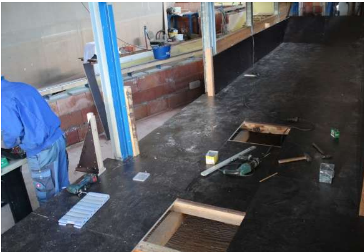
Abbildung 24: AgF - Schließung Wellenkanal
