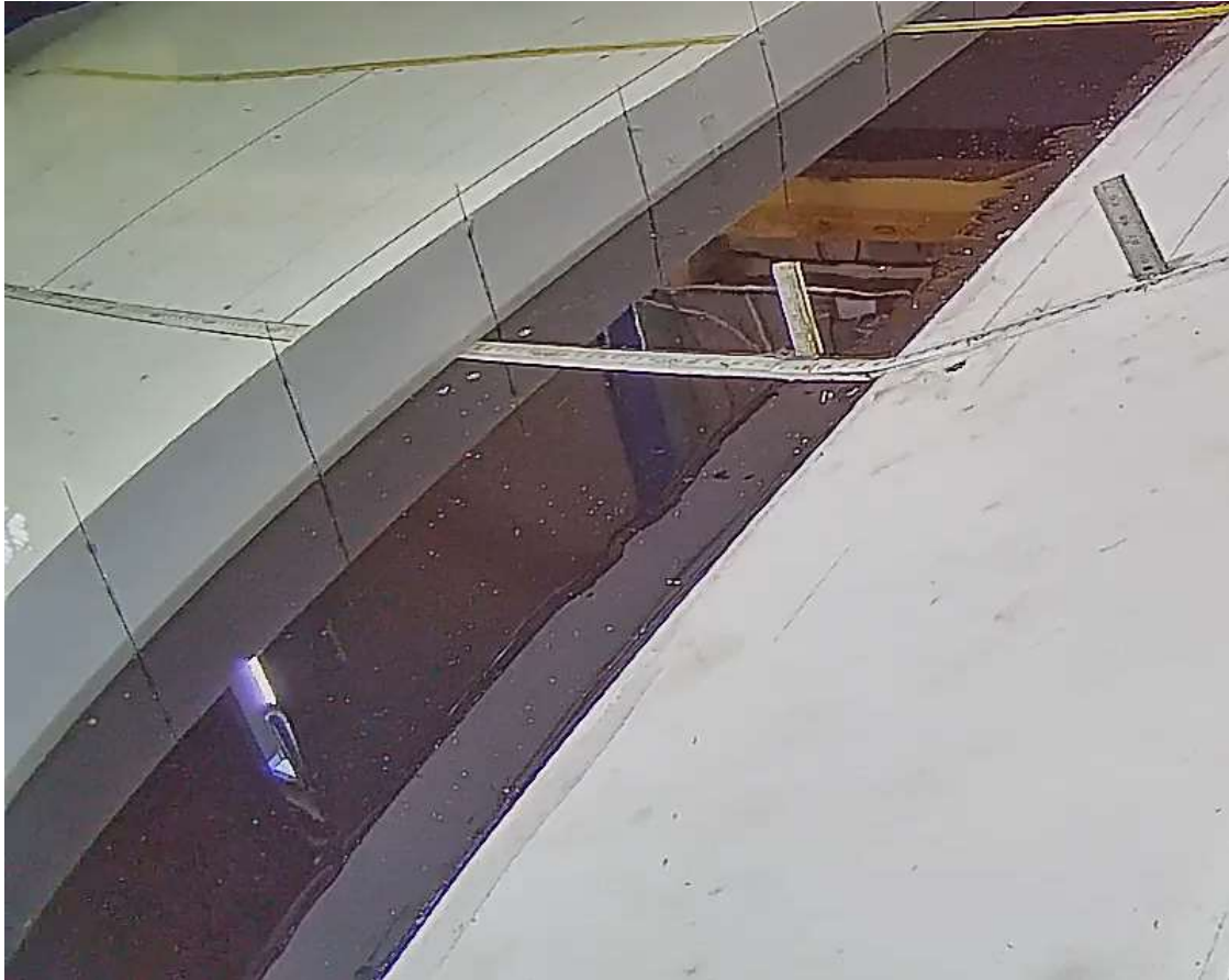
Abbildung 33: AgF – eingebauten techn. Schilfgürtel mit Widerstandsstäben (Ausschnitt) und Höhenmarkern
