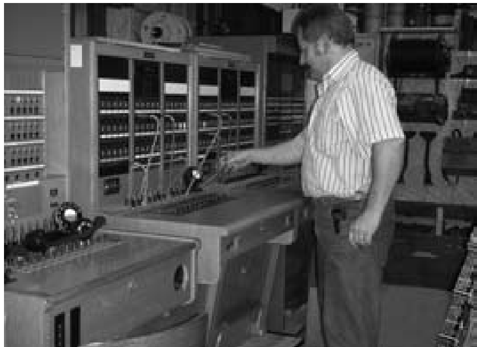
Diese Telefonzentrale Hasler H60 wurde in der Ursprung-Festung in Büren vom Telefonisten bedient.
