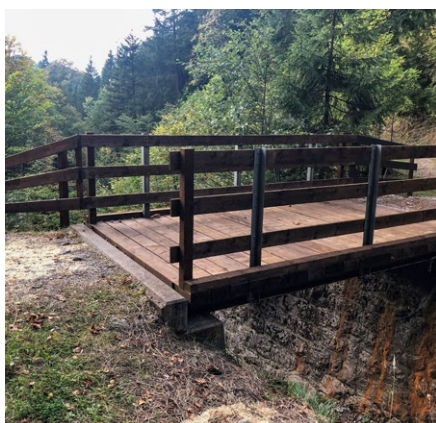
Bleikibachbrücke vor und nach Sanierung
