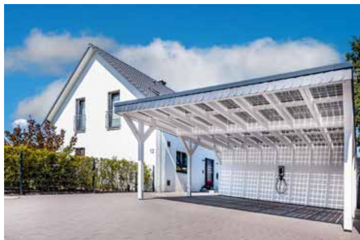
Das Solarcarport macht unabhängiger von den öffentlichen Netzen und zukünftigen Preissteigerungen.
