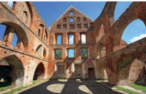
Wirtschaftsgebäude auf dem Klostergelände
