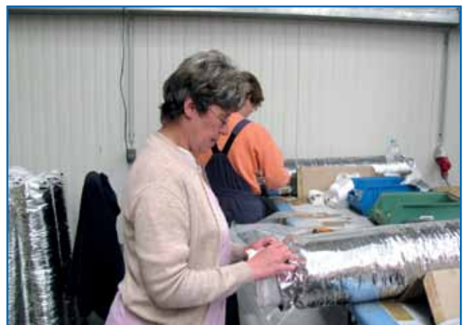
Montage flexibler Lüftungsrohre
