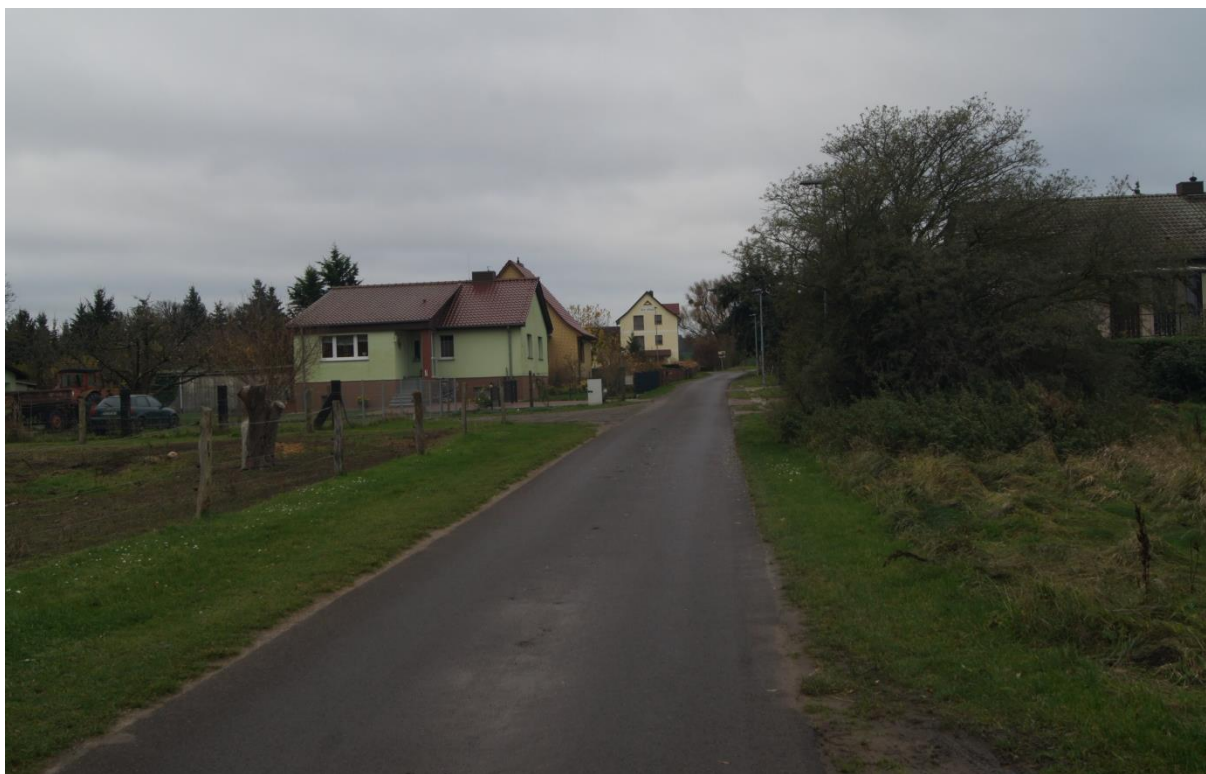
Bild 01 Ortsdurchfahrt Feldstraße westlich des Plangebietes
