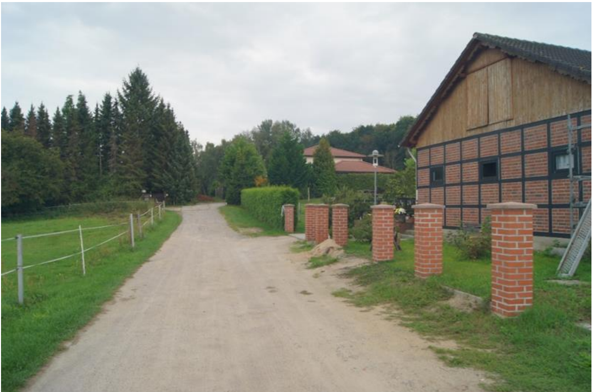
Bild 02: angrenzender Weg mit Stallgebäude und Wohnhaus; von West nach Süd fotografiert
