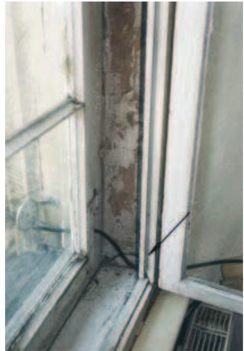
Abb. J: Quetschfalzkonstruktion
